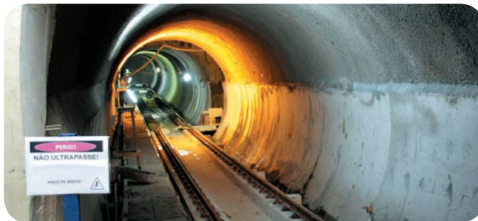
Construção do metrô, no Rio de Janeiro.
